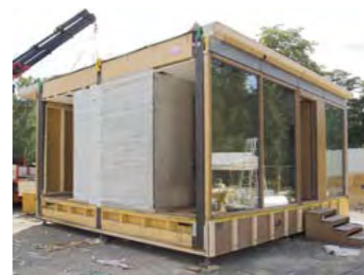
Das Haus kann in gleich große Raummodule zerlegt werden. Die einzelnen Module sind auf Transportmaß
