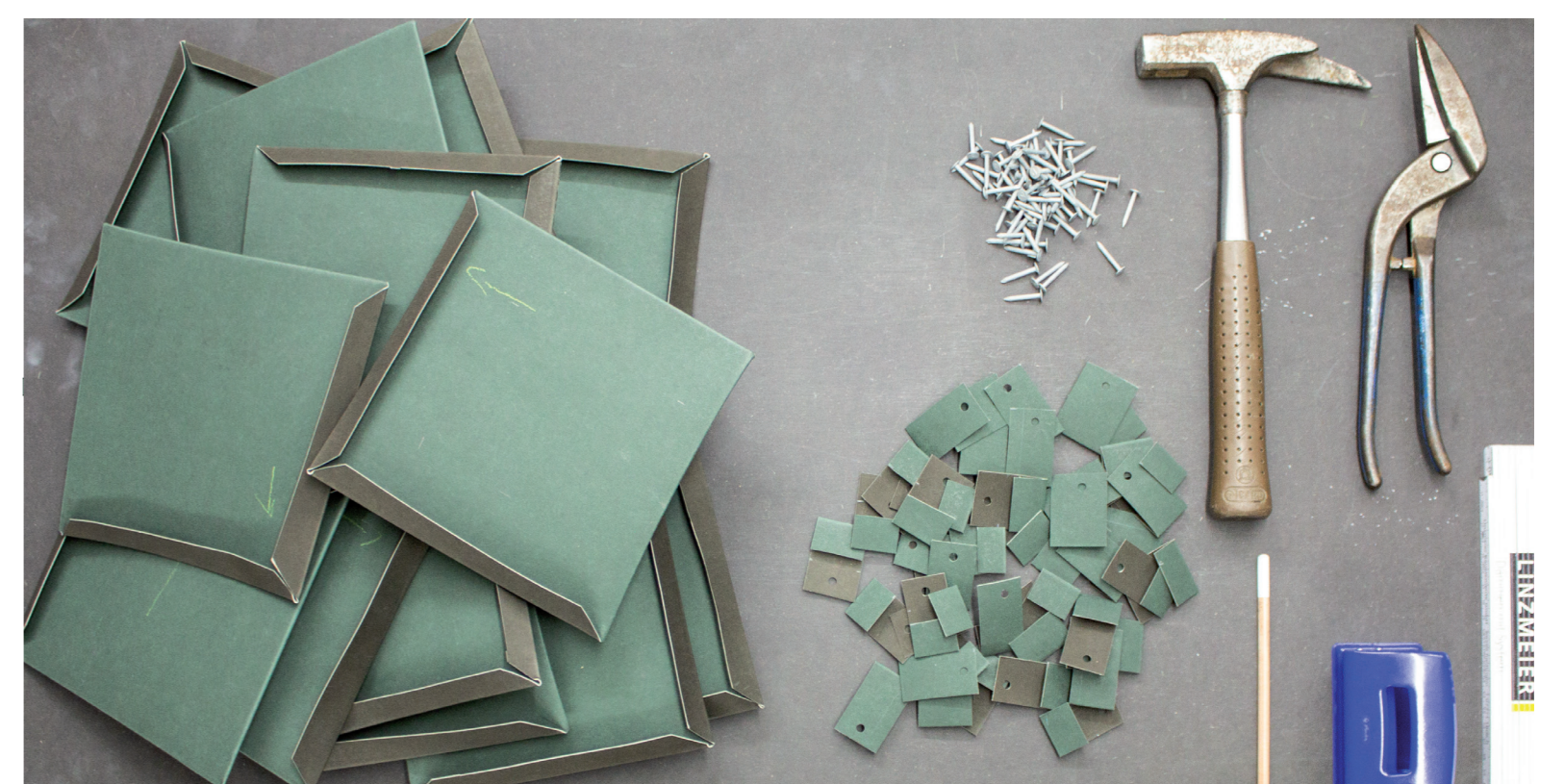
Bild 3 Benötigte Materialien und Werkzeuge für die Schuppendeckung
