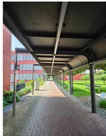
Durchgang zum Architekturgebäude
